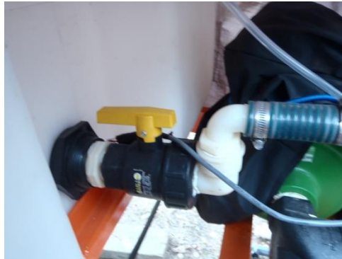
Fill valve in fill position
